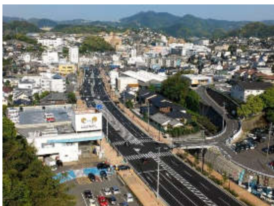
横道工区の供用状況
