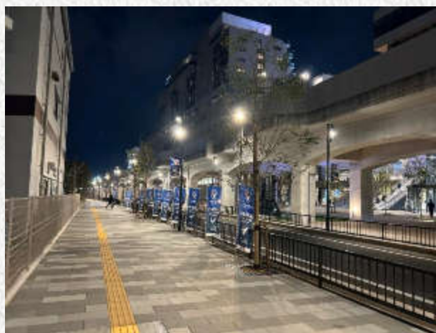
JR長崎本線連続立体交差事業 （長崎駅東通り線）
