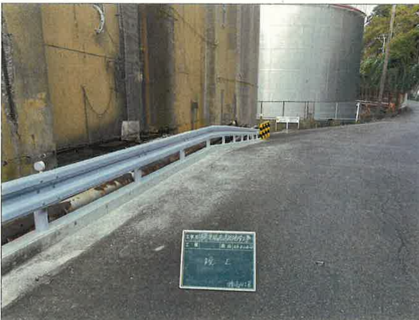
写真区分: 着手前及び完成写真 工種: 竣工 写真タイトル: 竣工 撮影箇所: No. 0-No. 10
