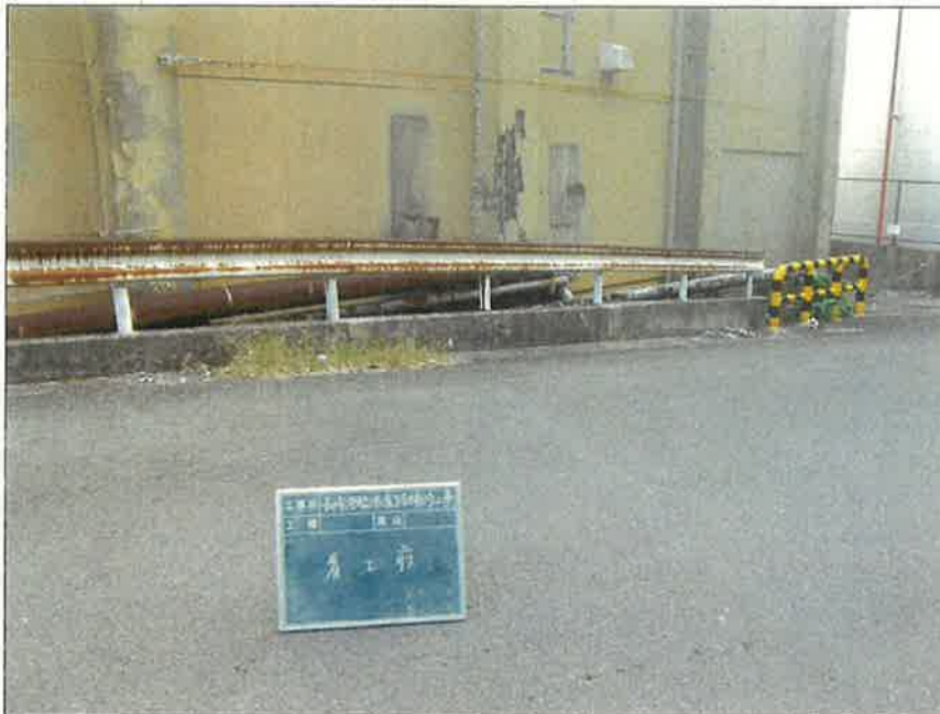
写真区分: 着手前及び完成写真 工種: 着工前 写真タイトル: 着工前 撮影箇所: No. 10-No. 18.5
