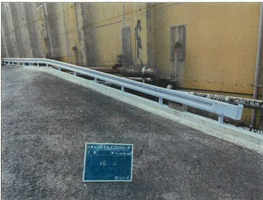
写真区分: 着手前及び完成写真 工種: 竣工 写真タイトル: 竣工 撮影箇所: No. 10-No. 18.5
