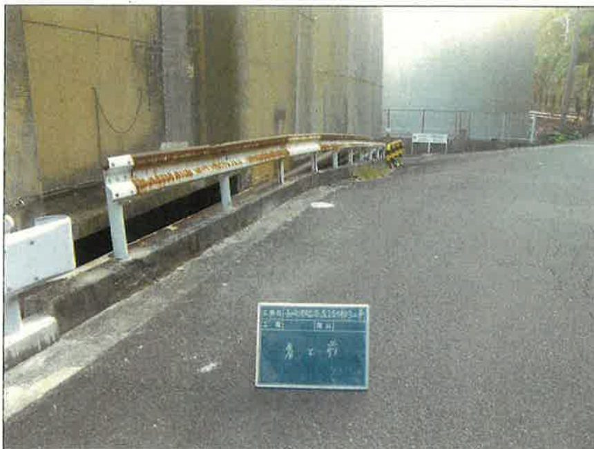
写真区分:着手前及び完成写真 工種:着工前 写真タイトル:着工前 撮影箇所:No. 0-No. 10
