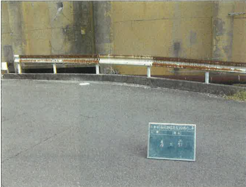
写真区分:着手前及び完成写真 工種:着工前 写真タイトル:着工前 撮影箇所:No. 0-No. 10
