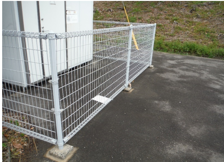
既存フェンス
