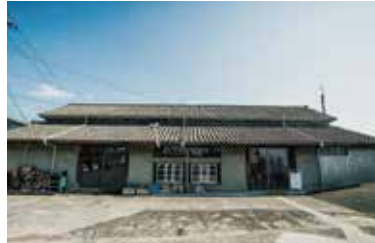
旧千綿村農協米倉庫
