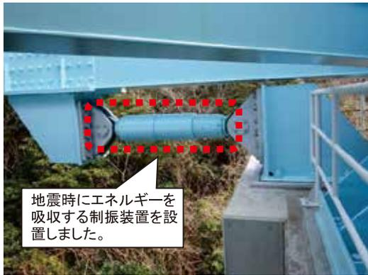
地震時にエネルギーを吸収する制振装置を設置しました。
