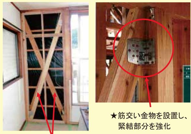
★筋交いによる補強工事
