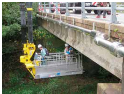
橋梁の定期点検状況
