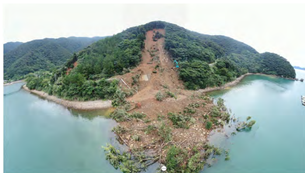
ドローン等のICT技術による調査
