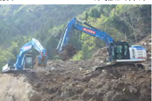
土砂撤去作業
