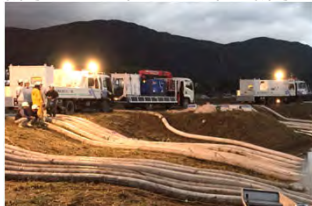
排水ポンプ車による緊急排水
