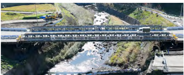
応急組立橋による交通路の確保
