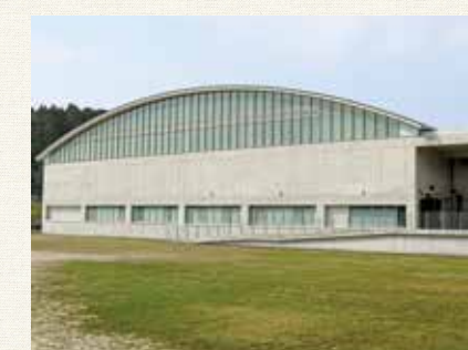
⑦ 体育館外観
