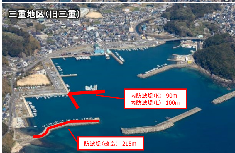
三重地区(臨港道路 畝刈時津線・畝刈琴海線)
