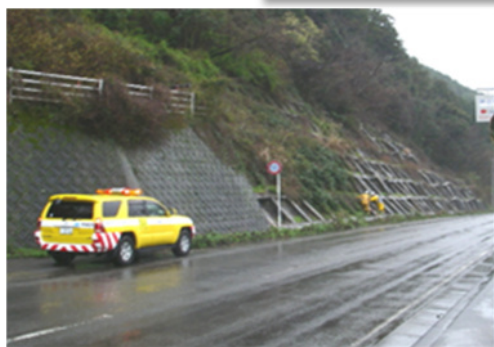
通常点検(道路パトロール)
