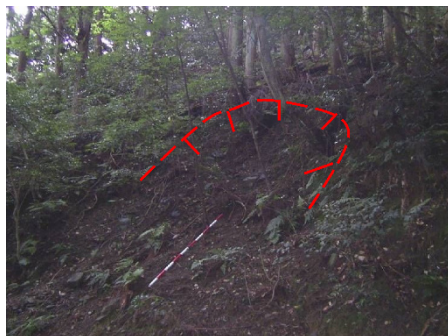
法面崩壊(自然斜面)
