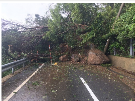
落石・崩壊((主)獅子津吉線 R3.8 発生)
