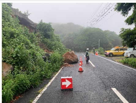
落石・崩壊((一)俵ヶ浦日野線 R6.5 発生)
