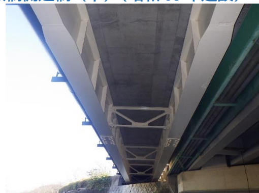
〈対策後（塗替え塗装工）〉
