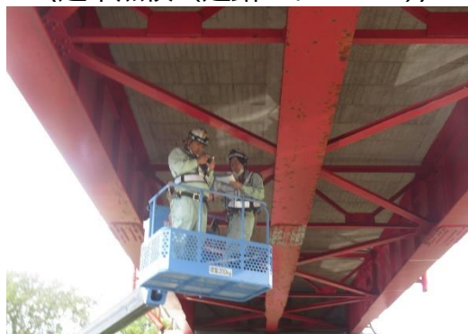
〈定期点検（リフト車で実施）〉
