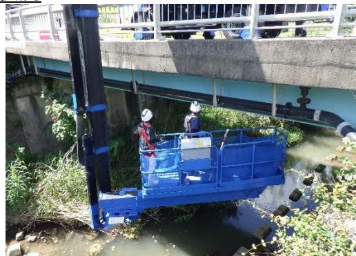
〈定期点検（橋梁点検車で実施）〉
