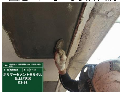
〈補修—断面修復工〉
