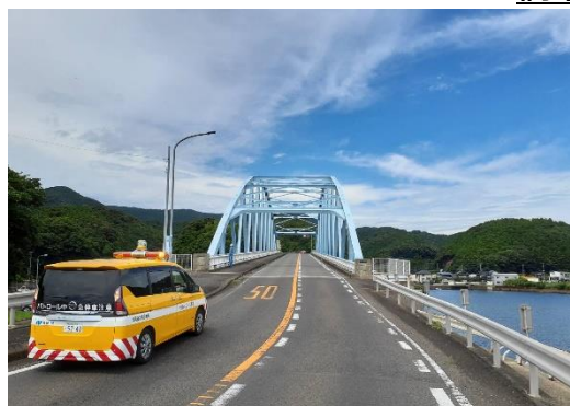
〈通常点検（道路パトロール）〉
