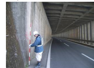
写真-3.4.1 点検写真の撮影例 (起点側からの撮影の例)
