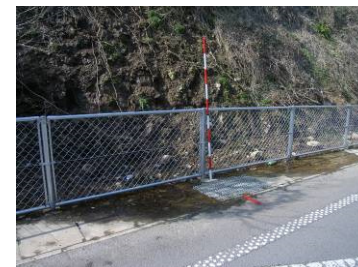
斜面下ののり尻からの湧水の例 (主要地方道小浜北有馬線)
