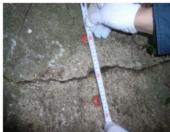
写真-3.4.5 点検写真の撮影例 (金属標による観測位置の撮影の例)
