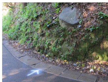
写真-3.4.4 点検写真の撮影例 (フットマークによる観測位置の撮影の例)
