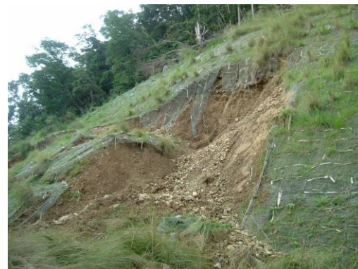
斜面の崩壊跡の例 (対馬市の一例)
