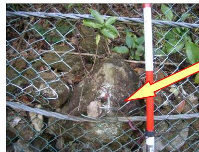
落石対策工(落石防護柵網)の破損の例 (一般県道雲仙千々石線)
