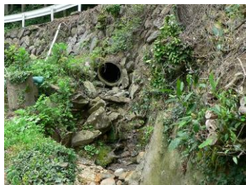
排水溝の吐口部周辺の洗掘の例 (佐世保市の一例)
