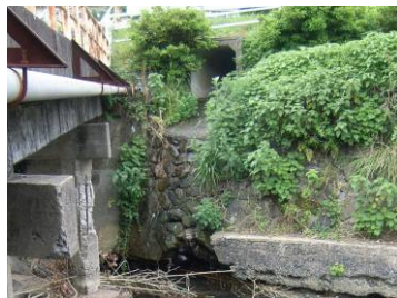
排水溝の吐口部周辺の洗掘の例 (佐世保市の一例)
