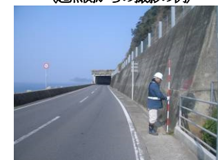
写真-3.4.2 点検写真の撮影例 (終点側からの撮影の例)
