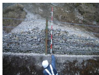
防災点検状況 (変状の進展状況の確認風景)
