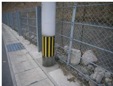
写真-3.4.3 点検写真の撮影例 (新たな変状等が確認された箇所の撮影の例)
