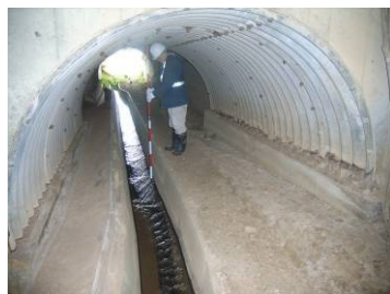
盛土部横断排水の点検の例 (一般国道 251 号)
