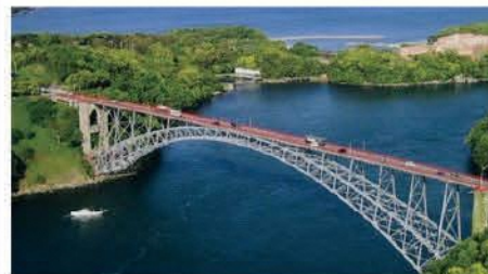
写真 西海橋（1955年供用） 一般国道202号 佐世保市～西海市
