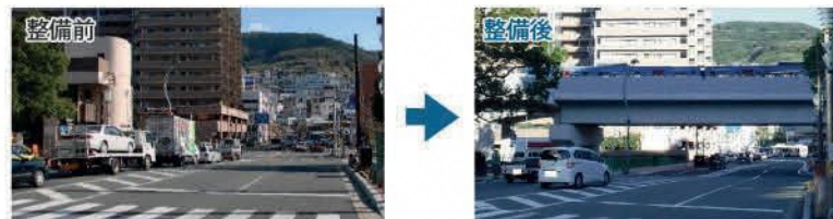
写真 J R長崎本線連続立体交差事業(梁川橋踏切付近)
