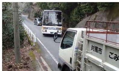
写真 大型車の離合が困難な未改良区間 (主) 厳原豆酸美津島線 (対馬市厳原町)
