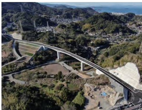
写真 西彼杵道路（時津工区）
