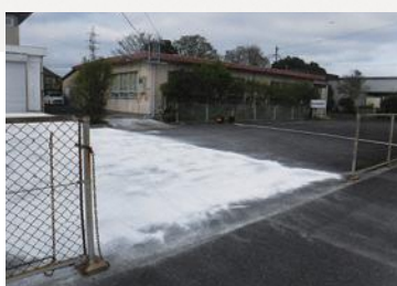
4 出入口①は消石灰を散布しています
