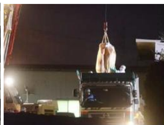
クレーン作業時の安全確認補助（フレコンバッグの積み込みはクレーンで実施）
