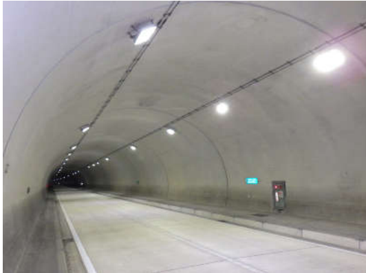
トンネル本体工
