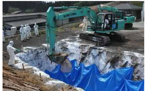
殺処分家畜投入作業
