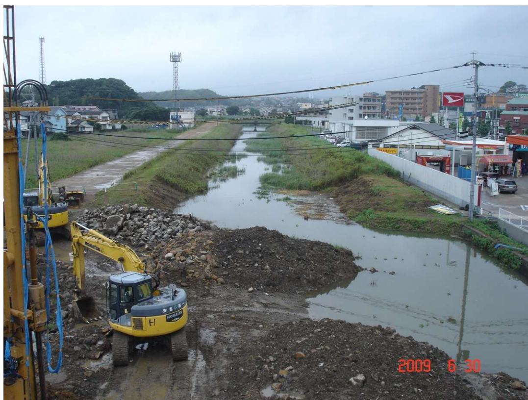
着工前 (H21.6.30) 日野橋より下流
