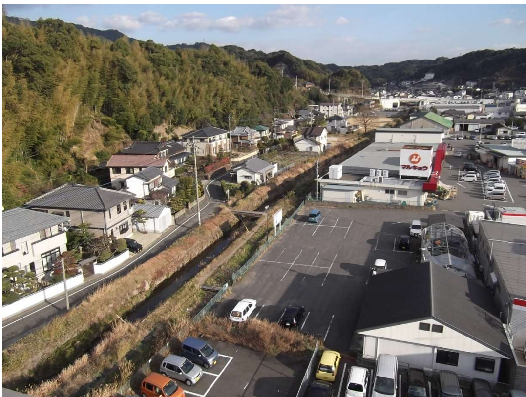
着工前 (H26.1.15) 牽牛崎橋より上流
