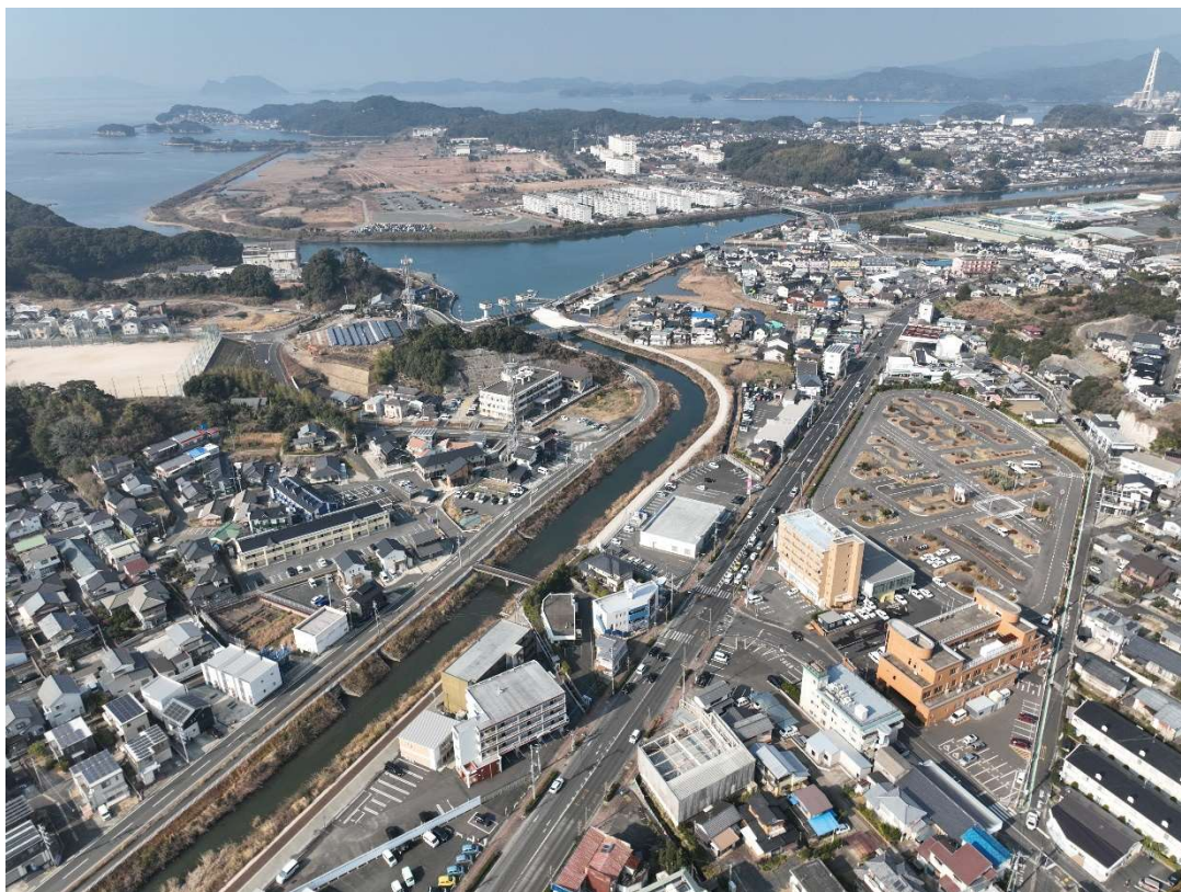
竣工(R7.1.21) 日野橋より下流
