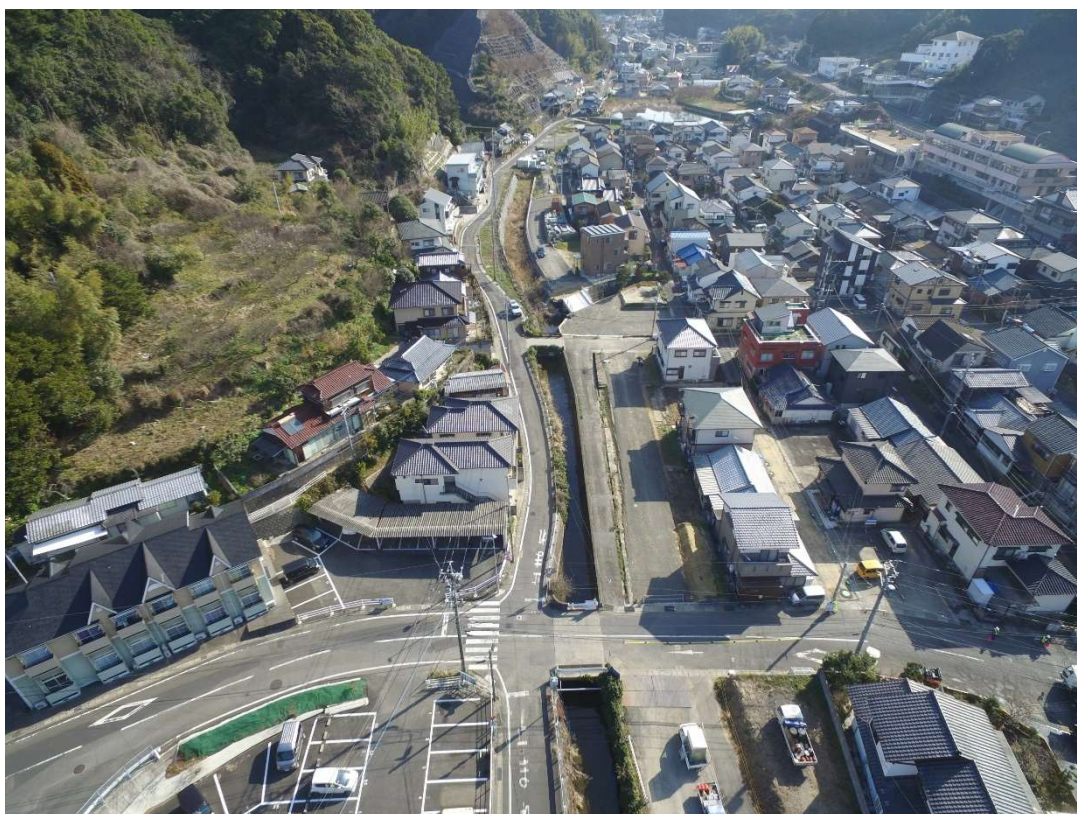
着工前 (H31.1.29) 駕田尾橋より上流
