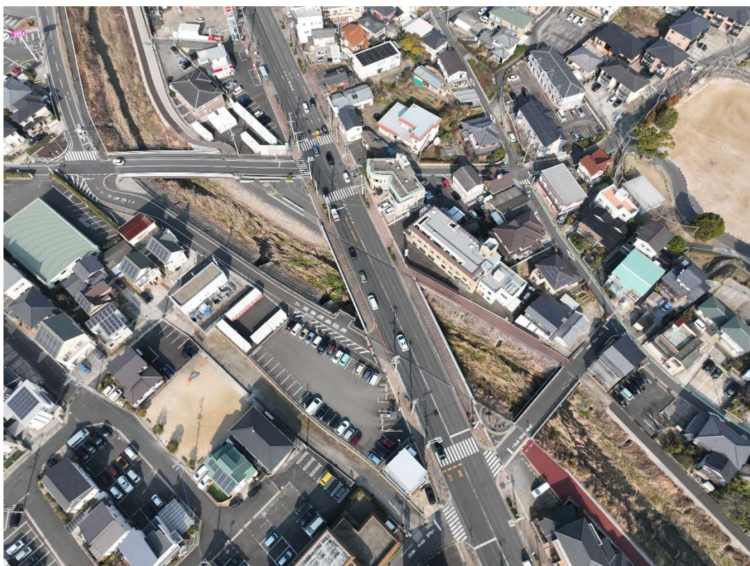
竣工(R7.1.21) 牽牛崎橋
