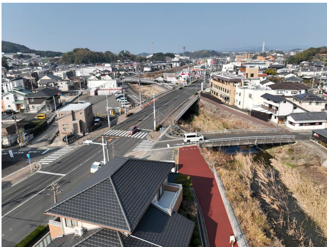
竣工 (R7.1.21) 牽牛崎橋
