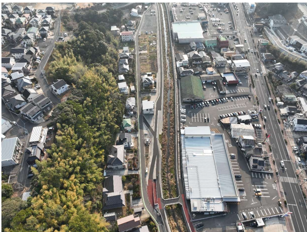
竣工 (R7.1.21) 牽牛崎橋より上流
