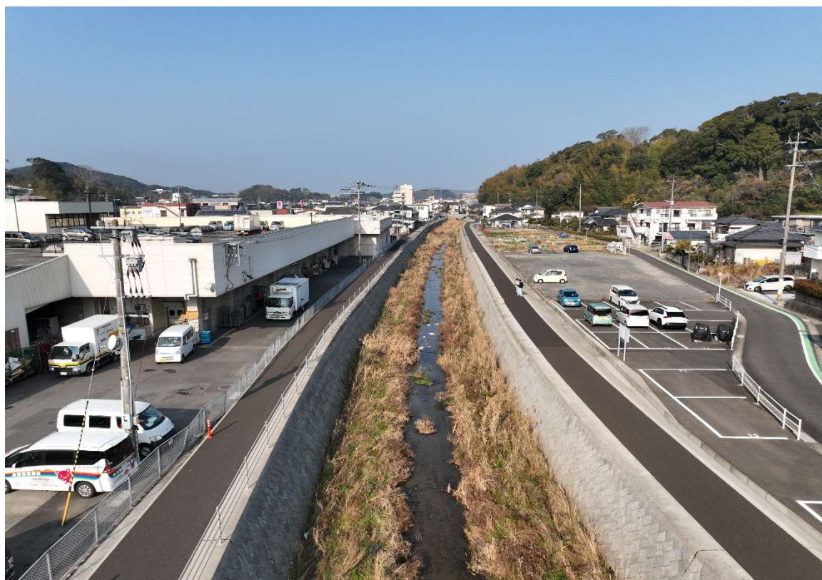
竣工 (R7.1.21) はこね橋より下流
