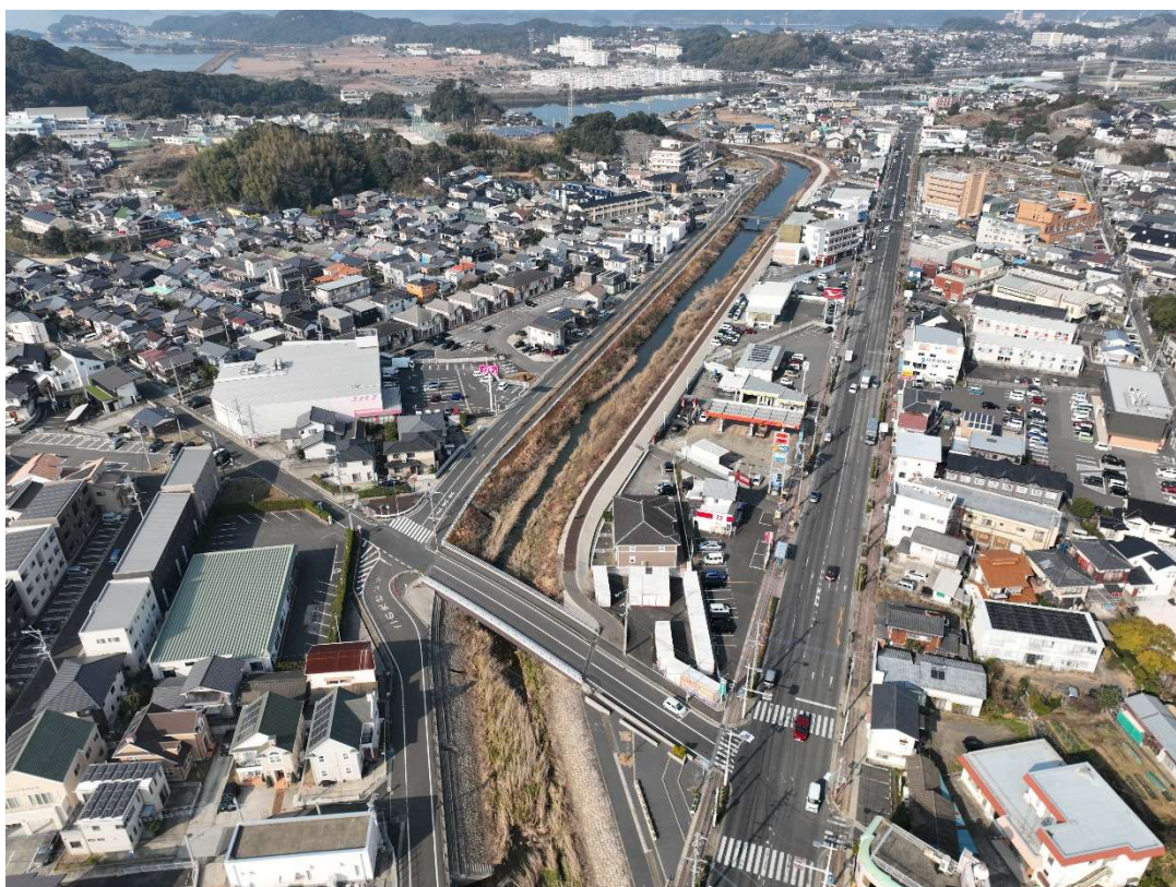
竣工 (R7.1.21) 牽牛崎橋より下流
