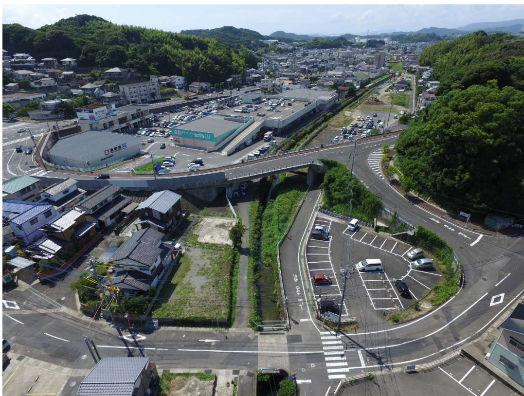
着工前 (H29.12.12) 駕田尾橋より下流
