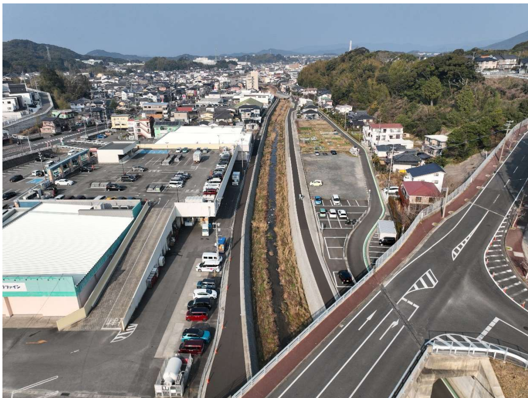
竣工 (R7.1.21) はこね橋より下流
