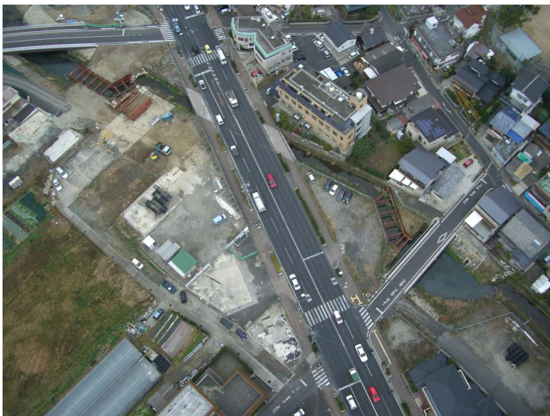
着工前(H22.1.6) 牽牛崎橋
