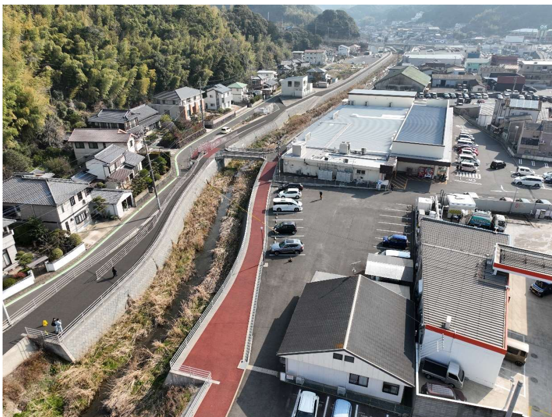
竣工 (R7.1.21) 牽牛崎橋より上流
