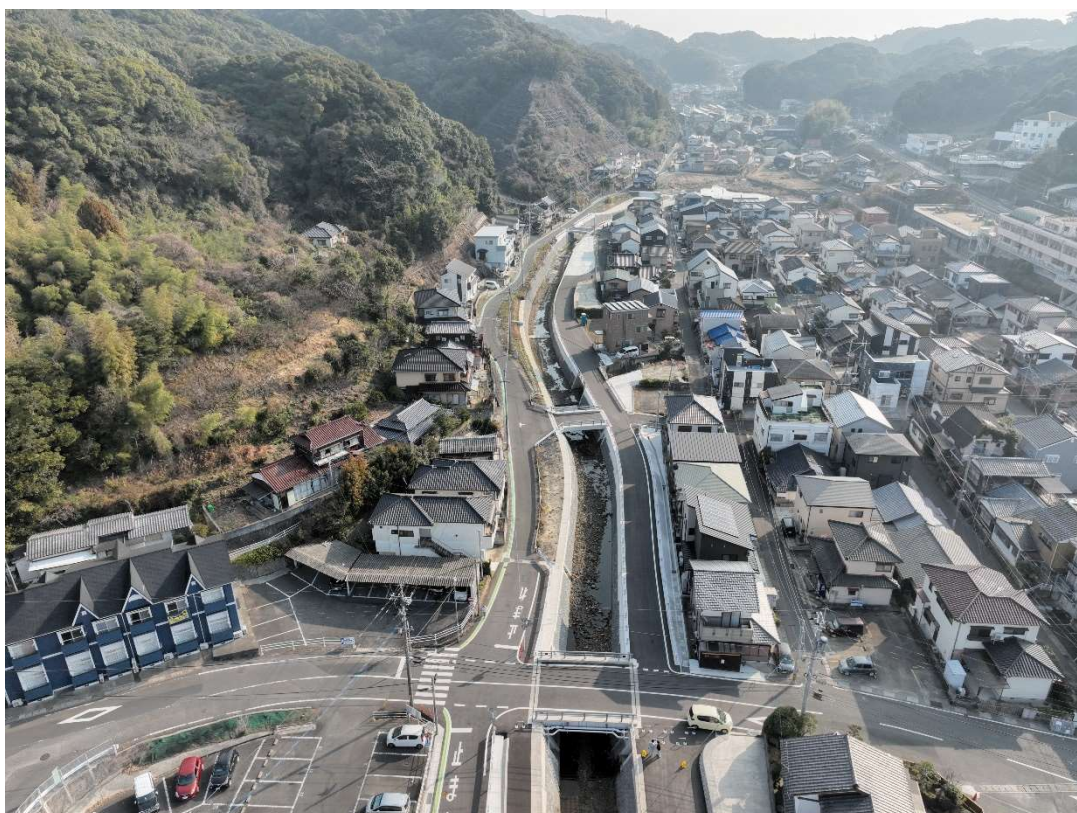
竣工 (R7.1.21) 駕田尾橋より上流
