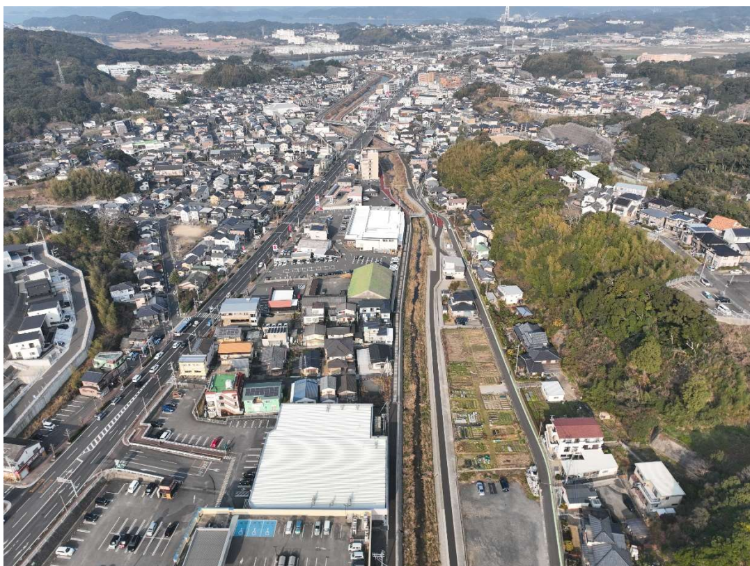
竣工 (R7.1.21) はこね橋より下流
