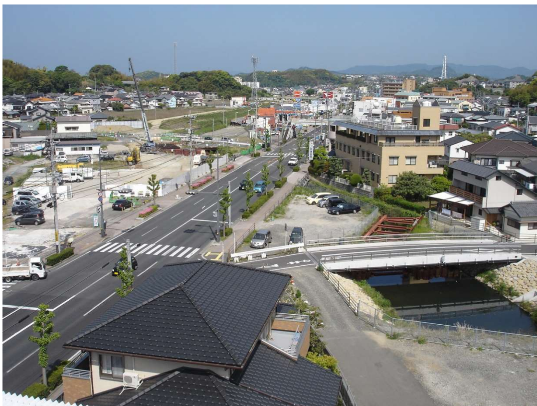
着工前 (H20.5.2) 牽牛崎橋
