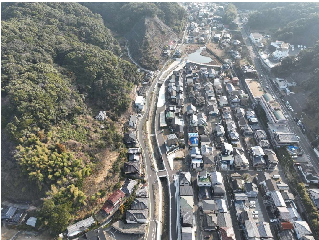
竣工 (R7.1.21) 駕田尾橋より上流
