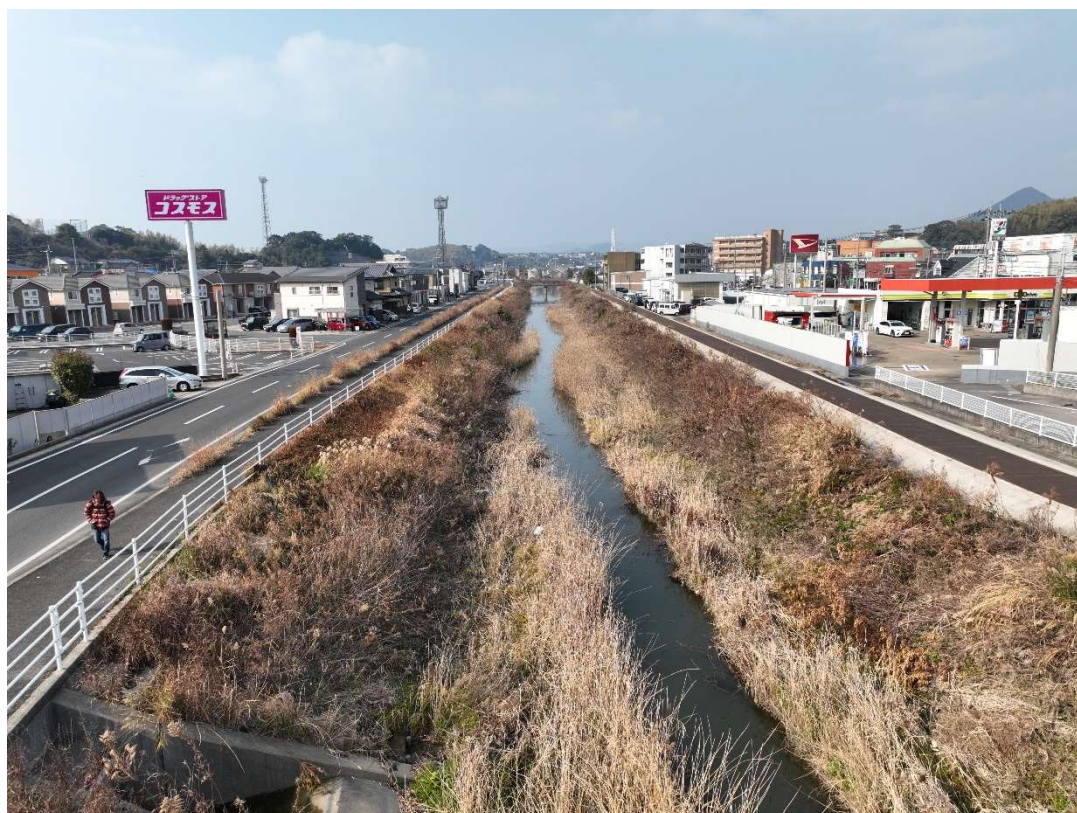
竣工 (R7.1.21) 日野橋より下流
