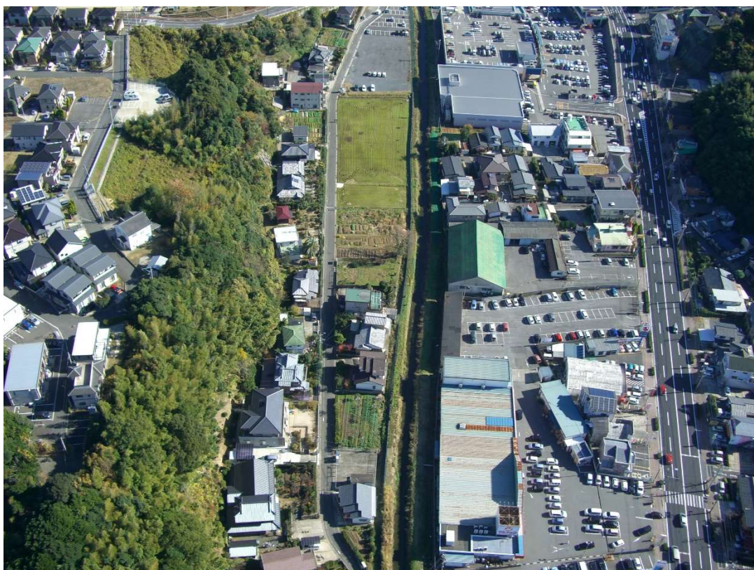
着工前 (H22.12.4) 牽牛崎橋より上流
