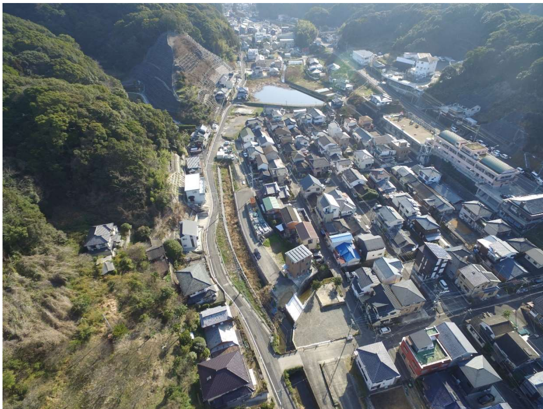
着工前 (H31.1.29) 駕田尾橋より上流
