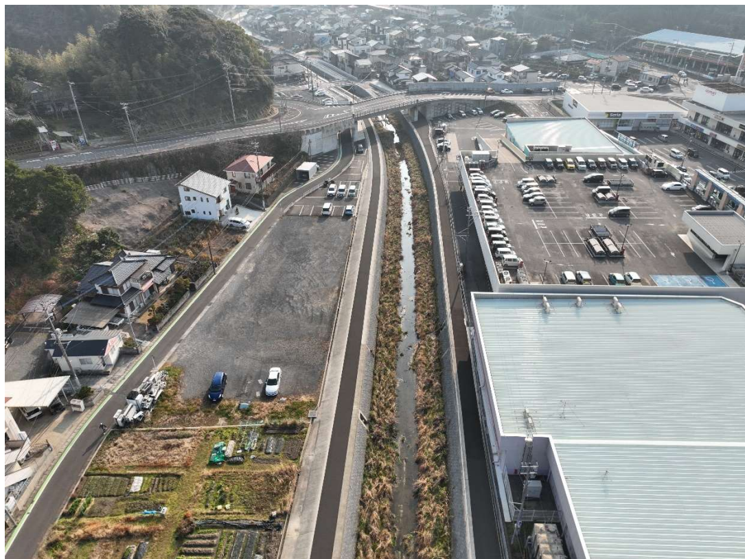
竣工 (R7.1.21) はこね橋より下流
