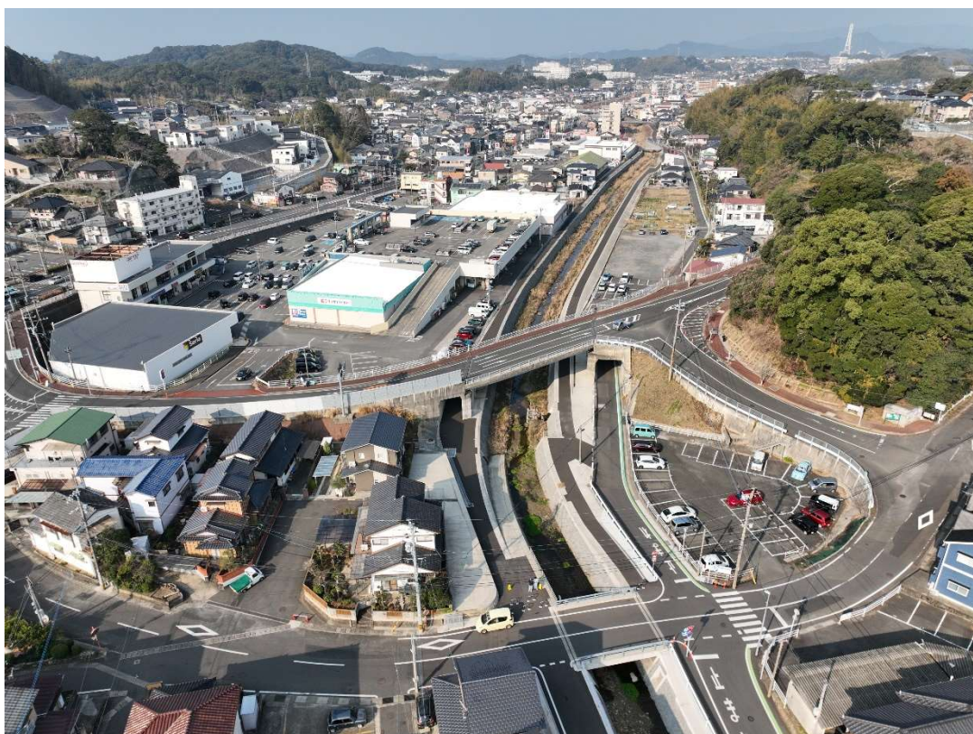
竣工 (R7.1.21) 駕田尾橋より下流
