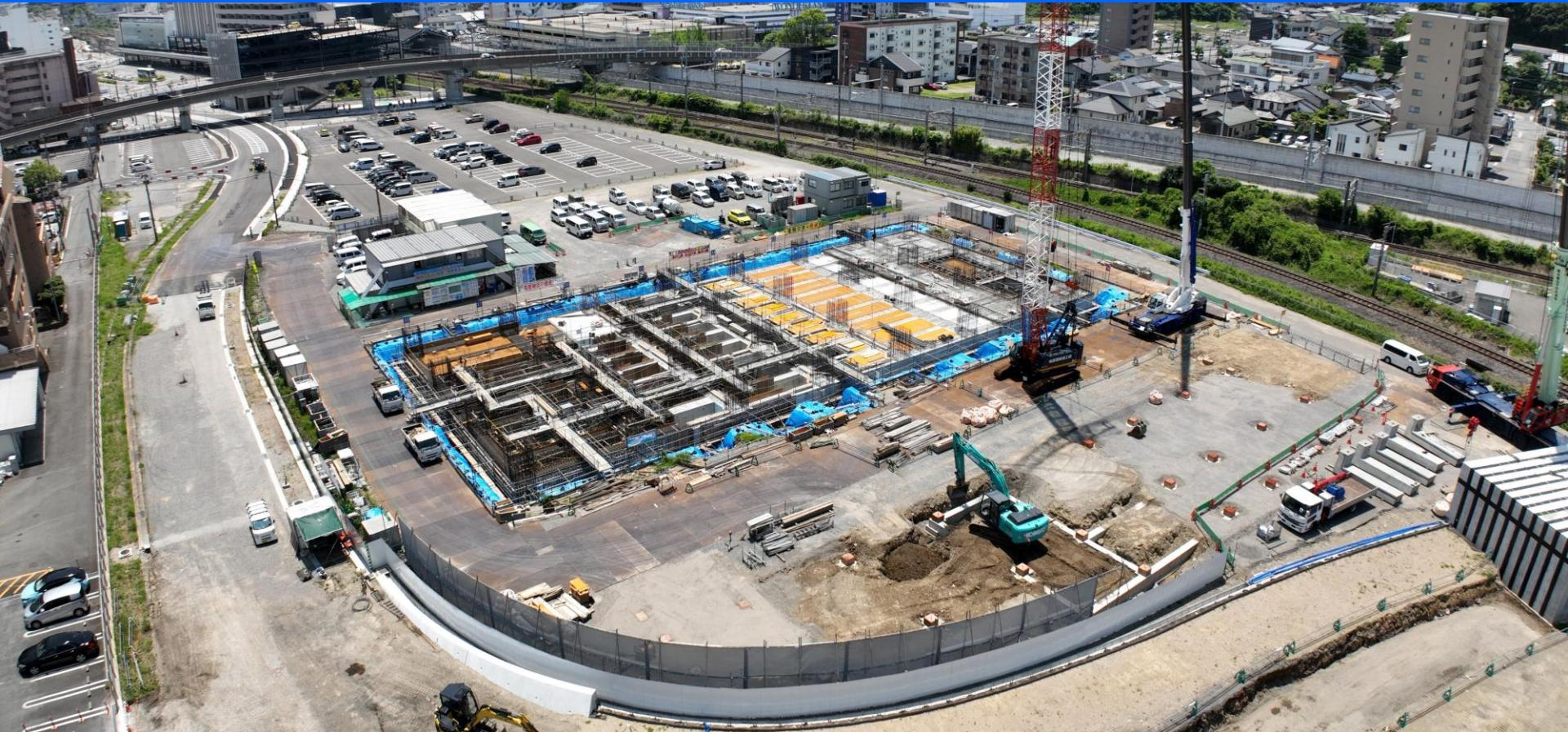
○庁舎の基礎・地中梁・1階床（一部）のコンクリート打設工事をしています。
