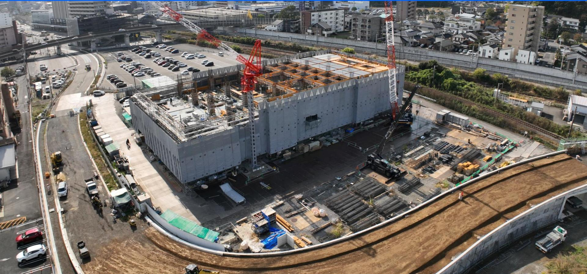
○庁舎3階床のコンクリート打設を完了し、柱及び梁の配筋、型枠の設置工事をしています。
