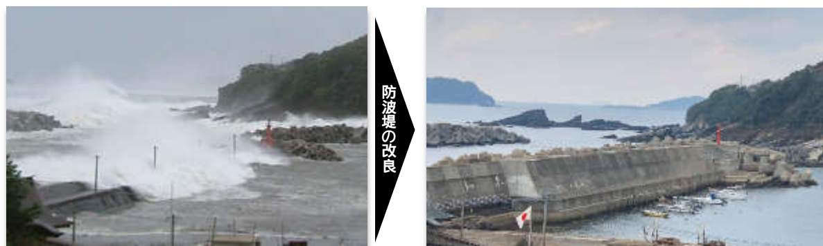
越波被害防止のための防波堤改良
