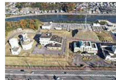
大村湾南部浄化センター
