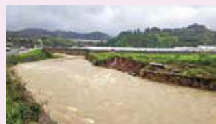
佐奈河内川(復旧前)
