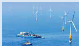
洋上風車(提供:戸田建設(株))
