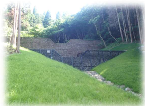
山地災害を防ぐための治山工事
