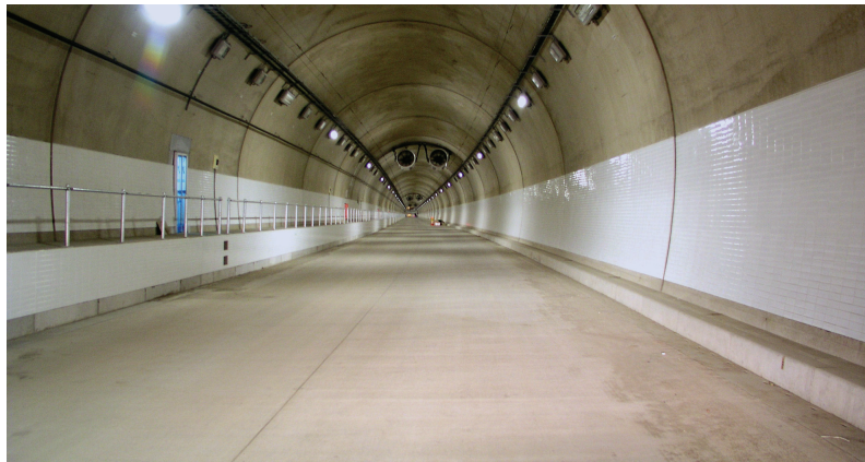
図8 長崎バイパス：オランダ坂トンネル
