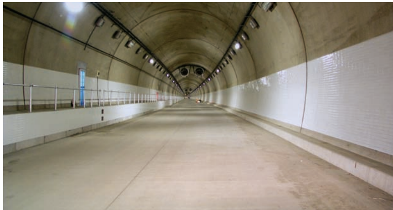
図8 長崎バイパス：オランダ坂トンネル
